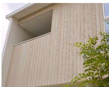
杉を使用したオリジナル木製外壁材『WALL WOOD』
