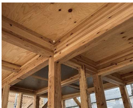
杉集成材を使用した構造材
